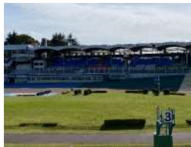
【メインスタンド】 耐震基準を満たしていないため閉鎖中
