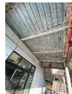
【正源氏プラザ】 落下した軒天井
