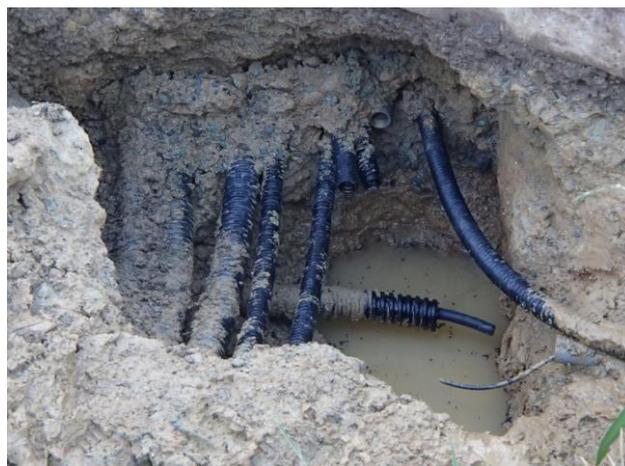
平成27年8月18日 選手宿舎裏水道管漏水(選手宿舎裏水道管より漏水(写真左)発生。その漏水が使用していないPF管(写真右)に流入し、漏水箇所より離れたバンク内に漏出したためバンク舗装を破壊した。
