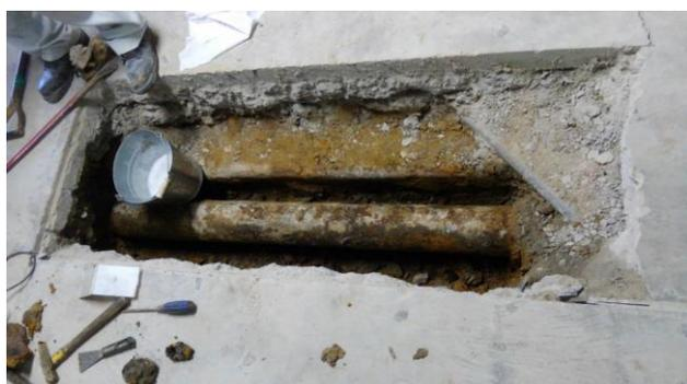
平成29年9月29日ガス漏洩 メイン特別観覧席1階警備研修室付近(鋼管老朽化による)
