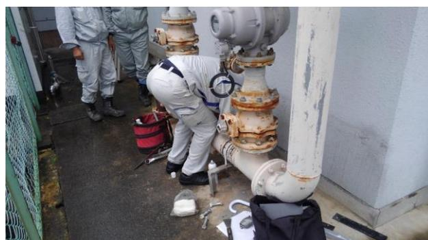
平成29年10月6日ガス漏洩 第5・6発売所吸収式冷温水機付近バルブ
