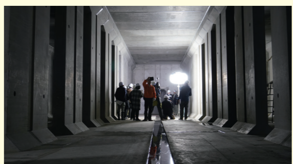
コンクリート柱を252本並べてできた地下空間を報道機関に公開
