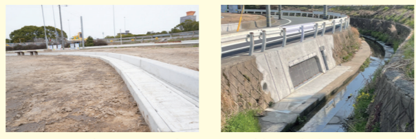
地上でも、園内に降った雨水をためられるよう縁石を設置中 下弓削川の支流から水を取り入れる部分
