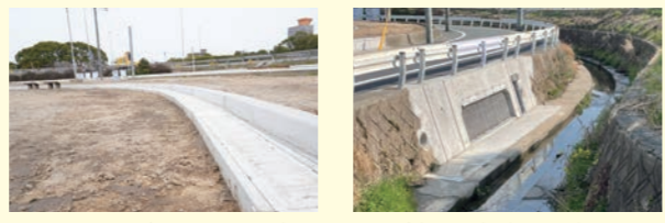
地上でも、園内に降った雨水をためられるよう縁石を設置中 下弓削川の支流から水を取り入れる部分
