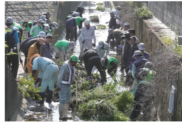
排水路の泥や草を取り除きました
