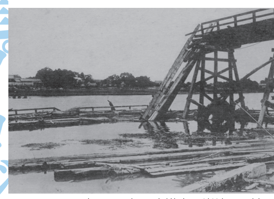
大正10年の大洪水で崩壊して流される宮ノ陣橋
