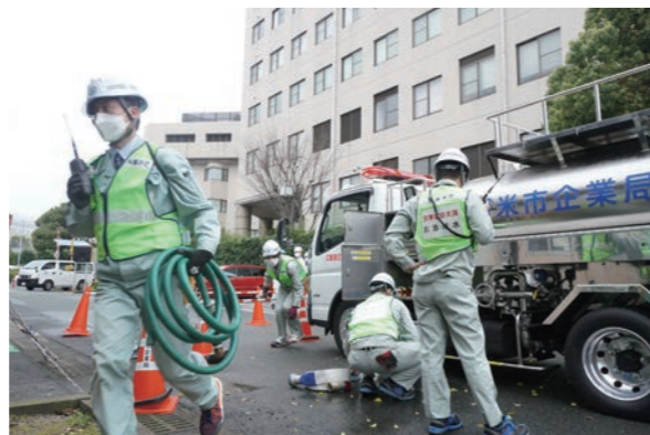
給水車の到着後、迅速に作業を実施。断水発生から1時間30分で給水作業が完了しました
