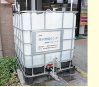
田主丸総合支所にあるタンクは水1トンをためられます
