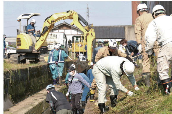
22日は、スコップや重機でたまった排水路の泥をかき出すしゅんせつ作業や除草を行いました
