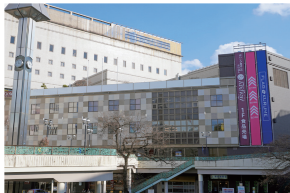
マーケティングラボが開設されるFLAG KURUME。駅に近く、きれいなオフィスで働きやすい環境です
