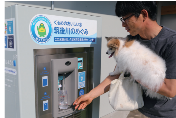
一度に300ミリリットルの水道水が出ます。マイボトルの大きさに合わせて利用ができます
