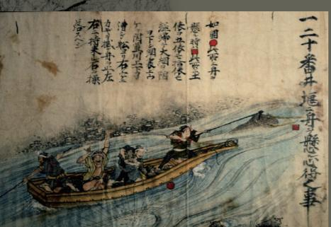
▲船をつなぎ一気に石を投げ入れる様子を描いた「床島堰築造絵図」。工事の心得、材木や石などの運搬の要領や器具の使い方が記されています
