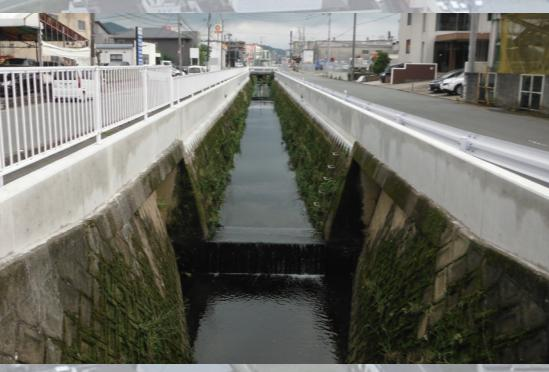
新たにコンクリート壁を作り、河川が上昇しても氾濫しないようにかさ上げをしています
