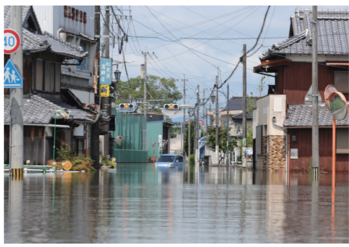
昨年の7月豪雨で浸水被害を受けた城島町中心部付近
