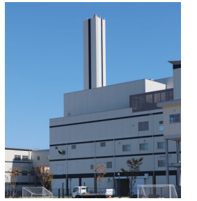
宮ノ陣クリーンセンター
