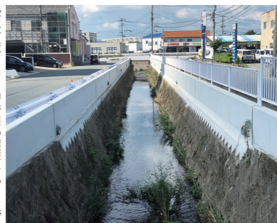
浸水対策として中谷川の護岸をかさ上げしました
