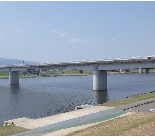
災害に備え、長門石橋の耐震化を進めています
