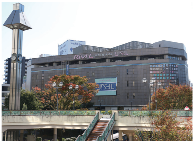
リバービルをはじめ、百貨店や多くのテナントが集まる西鉄久留米駅周辺
