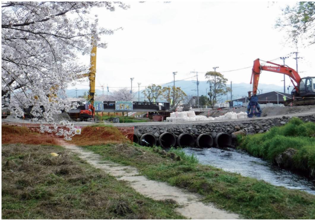
益城町内を流れる秋津川に架かる橋と護岸の工事の様子
