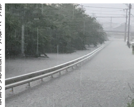
溢水して浸水した筒川沿いの道路
