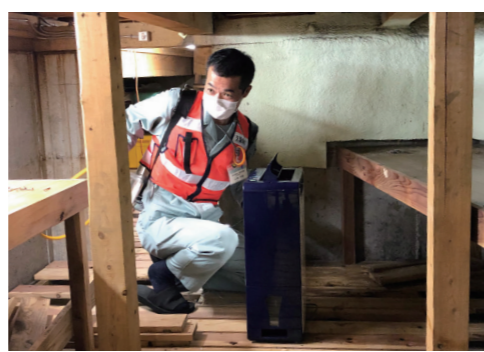
床下の消毒作業を行う派遣職員
