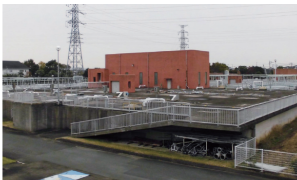
耐震化した中央浄化センター水処理施設第2プラント
