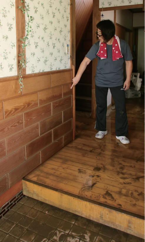
浸水面の跡を指さす飛永さん。8日朝の取材時には、玄関の壁にはっきりと痕跡が残っていました
