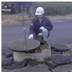
マンホールの調査を行う小柳さん
