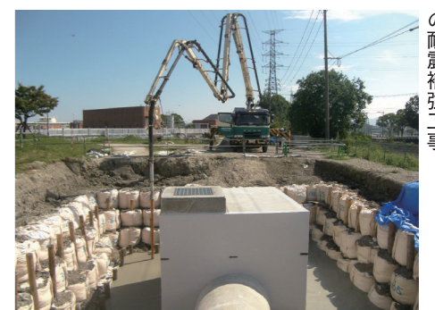
浄化した汚水を川へ放流する管の耐震補強工事
