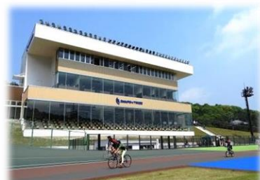
コンパクトに建てられた メインスタンド
