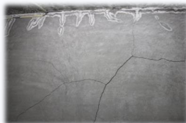
施設壁面の亀裂
