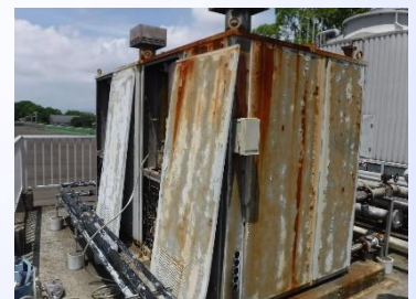
経年劣化で故障した空調機
