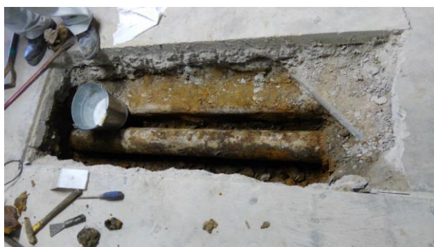
平成29年9月29日ガス漏洩 メイン特別観覧席1階警備研修室付近(鋼管老朽化による)
